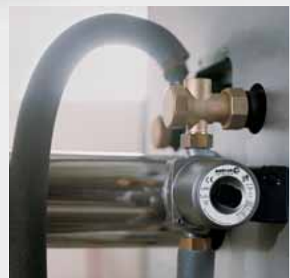
Bestens miteinander verbunden: das Ladepumpensystem der LogoBloc Unit LSL-UG und LSL-UB
